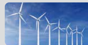
风力发电设备
